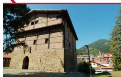
Legazpi dorretxea - Casa torre de Legazpi
